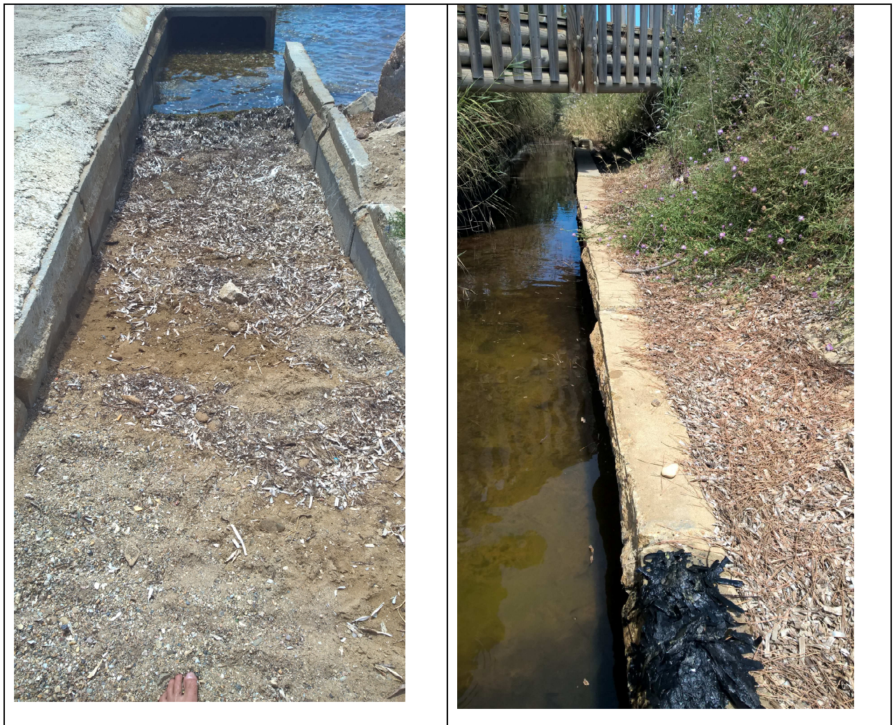
Figure 2-15 : Situation actuelle du débouché du canal à l'Est de la plaine du Bastidon (gauche : vue vers la mer ; droite : vue vers l'amont) (visite technique B. Waeles du 15/06/2017).
